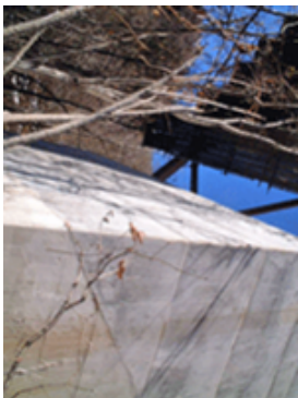
ひび割れ補修後
